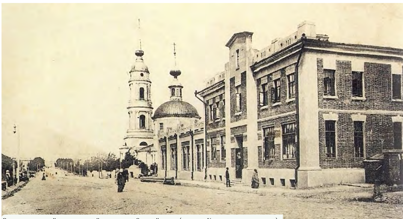
Здание калужской электрической станции на Садовой улице (совр. ул. Кирова, не сохранилось)
