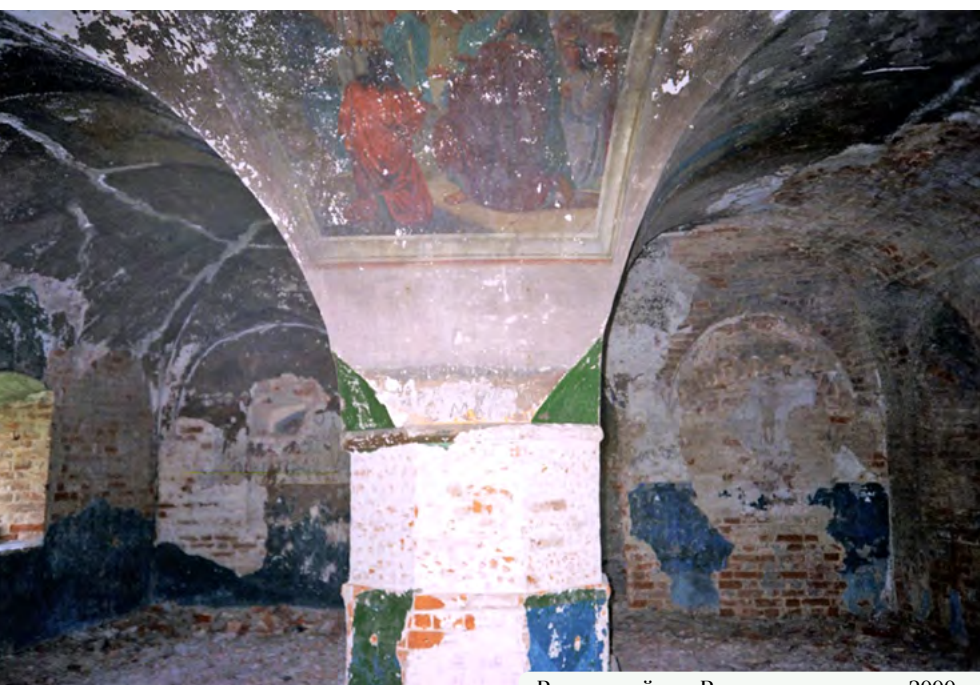
Внутренний вид Введенского храма в 2000 г.
