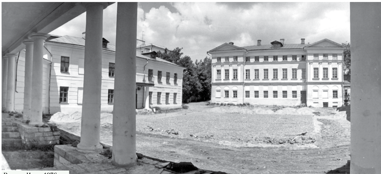
Ремонт. Июнь 1976 г.
