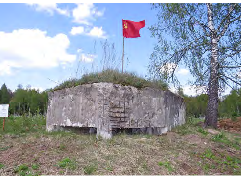
Командирский наблюдательный пункт с тремя смотровыми щелями. Село Ильинское
