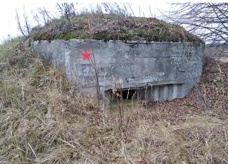
Пулемётный каземат тяжёлого типа фронтального обстрела на один станковый пулёмёт системы «Максим». Село Лукьяново
