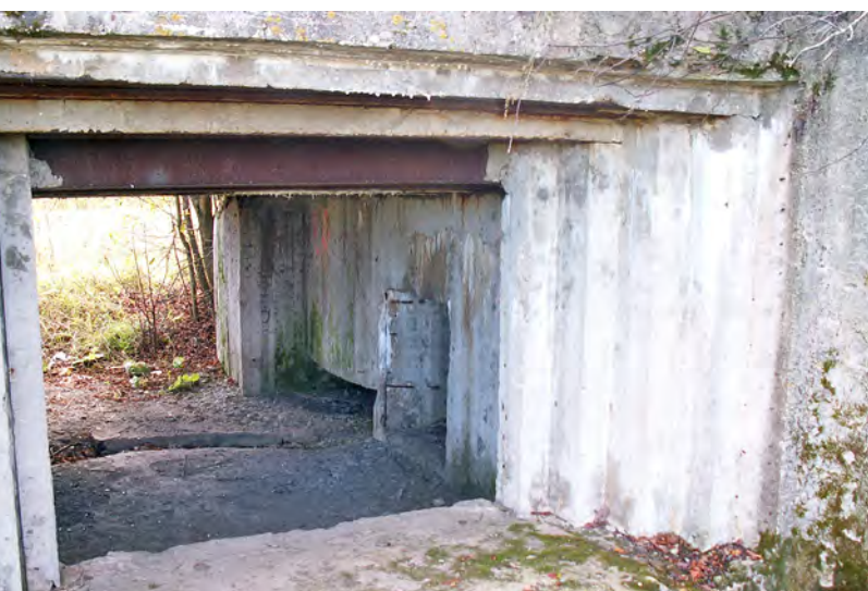
Амбразура и внутреннее обустройство орудийного усиленного каземата фронтального обстрела для 76-мм пушки. Село Ильинское
