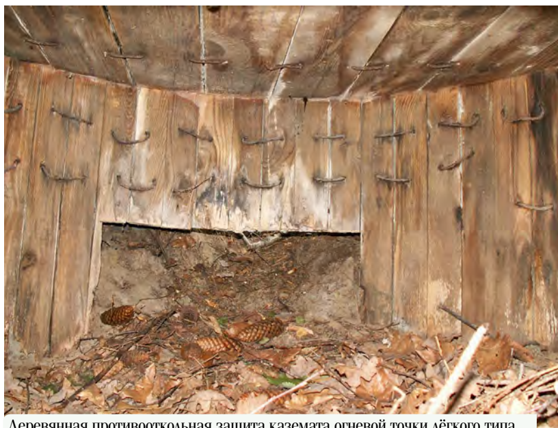
Деревянная противооткольная защита каземата огневой точки лёгкого типа
