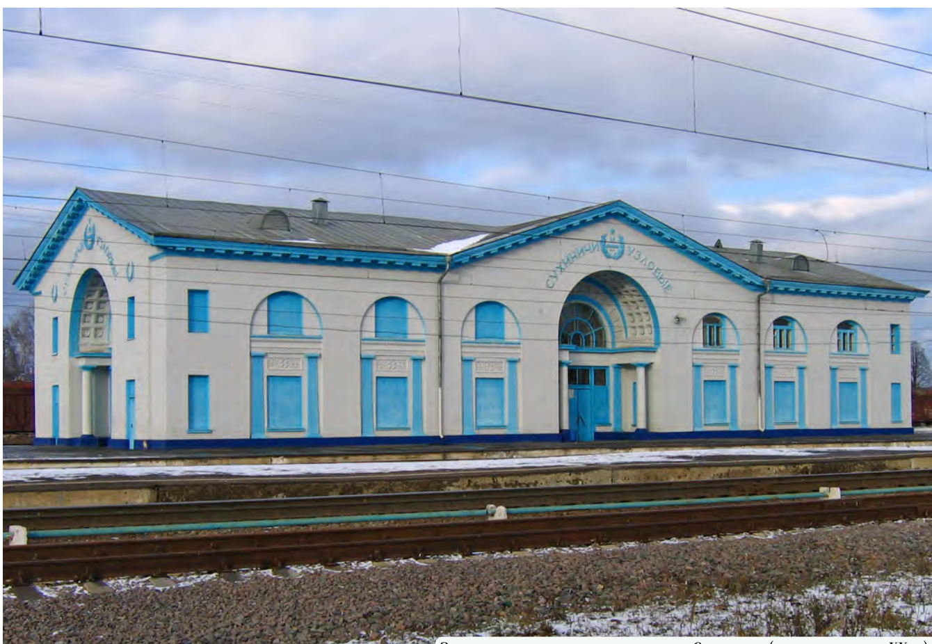
Здание железнодорожного вокзала в Сухиничах (строение начала XX в.)
