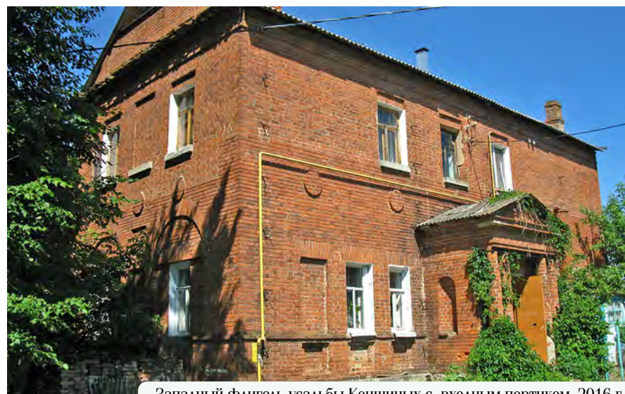
Западный флигель усадьбы Коншиных с входным портиком. 2016 г.
