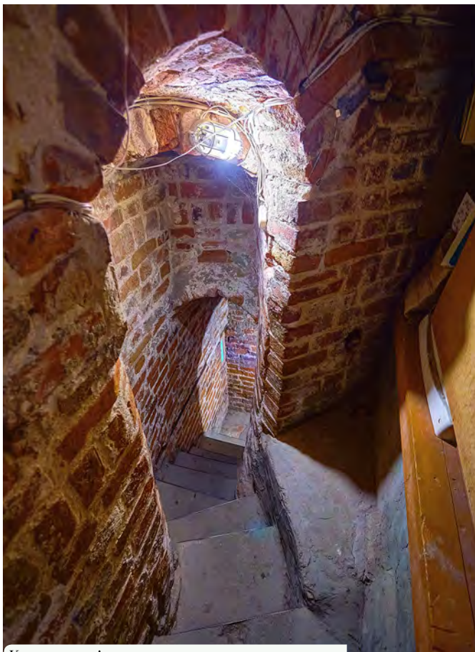
Колокольня. Лестничные пролеты на звонницу
