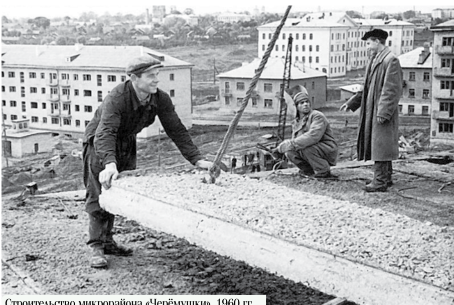
Строительство микрорайона «Черёмушки». 1960 гг.
