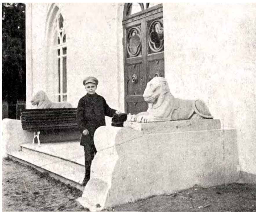
Подъезд готического дома со львами. 1916 г.
