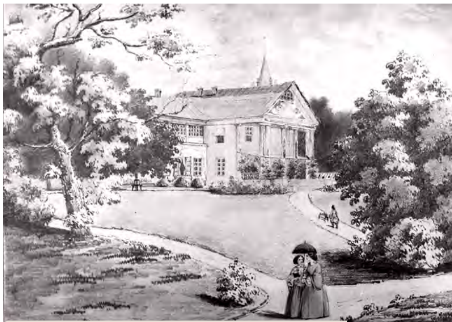
Авчурино. Общий вид старого деревянного дома. 1840–1860-е гг.
