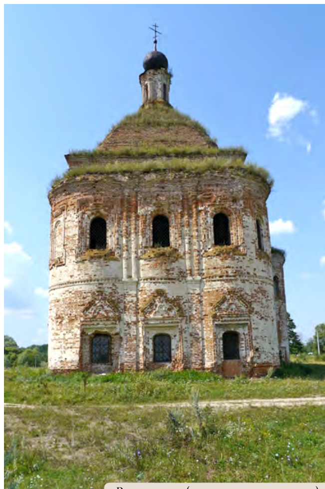
Вид с востока (до начала восстановления)
