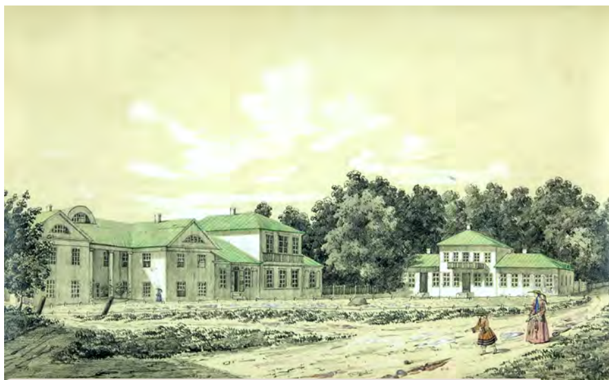
Старый главный дом и западный флигель. Вид с востока. 1840–1860-е гг.
