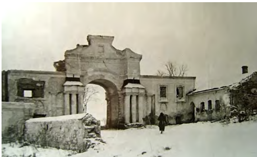
Спасские ворота и здание усыпальницы после освобождения Полотняного Завода. Зима 1942 г.
