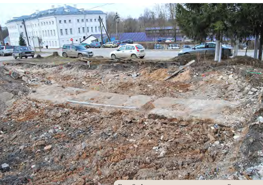
Рис. 9. Фрагмент основания западной стены
