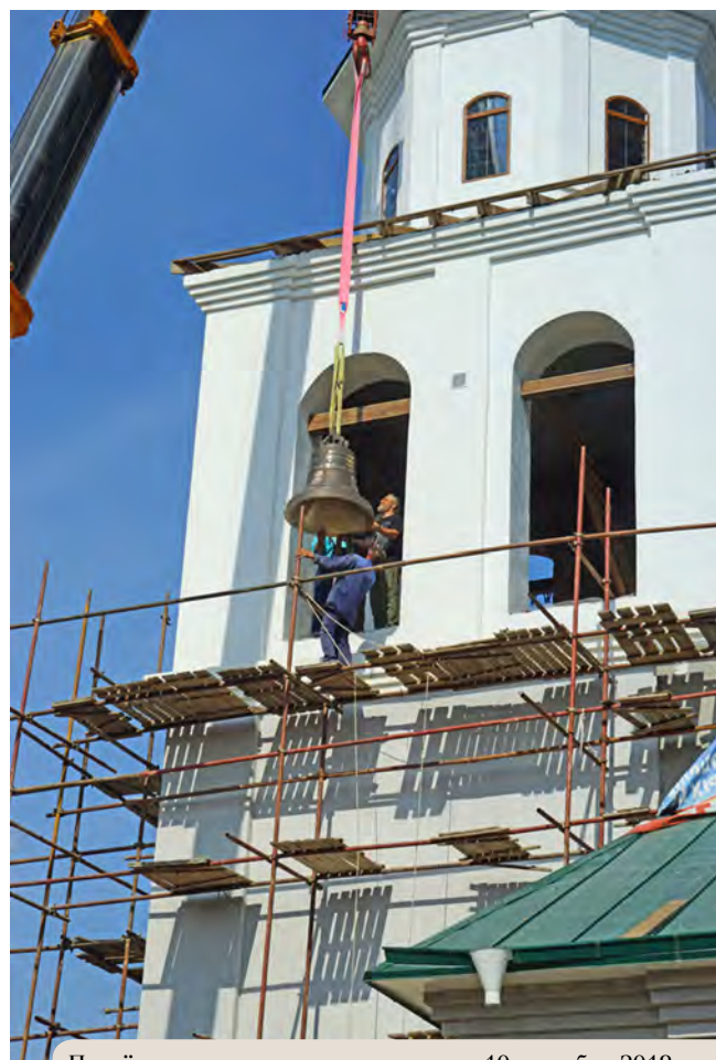
Подъём колоколов на звонницу храма. 10 сентября 2018 г.
