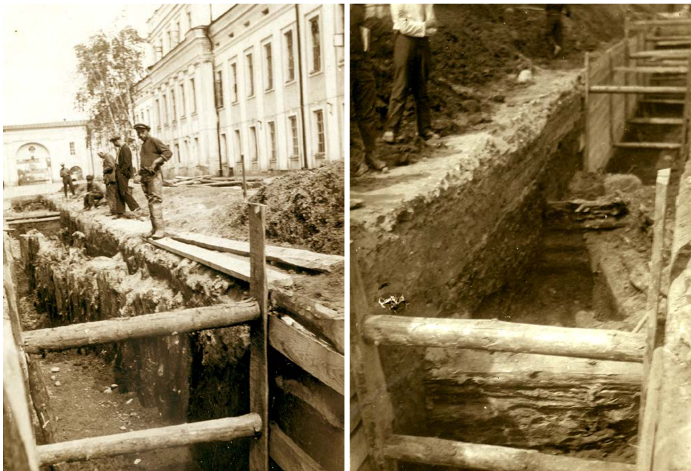
Рис. 3. Деревянные остатки калужской крепости, обнаруженные в ходе строительных работ 1935 г. по ул. Баженова
