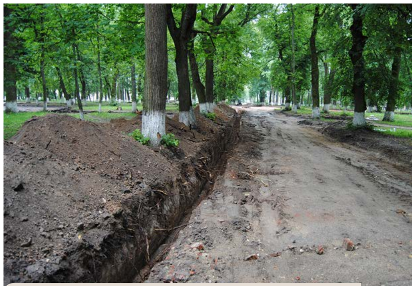
Рис. 4. Земляные работы на территории городского парка. 2010 г.
