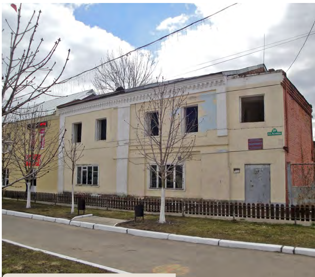
Здание типографии в Боровске до сноса
